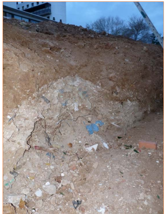
Foto 14. Vista del tall estratigràfic del nou col·lector d'aigües pluvials.
