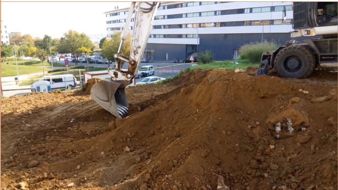
Foto 6. Vista del rebaix a la zona més a l'est del solar.
