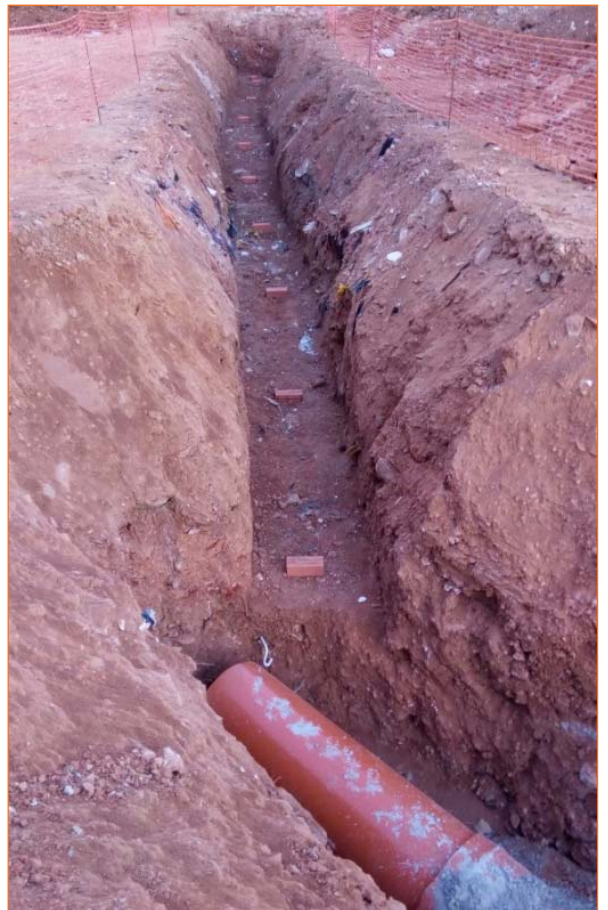
Foto 10. Vista de la Rasa pel nou col·lector d'aigües pluvials a la zona central.
