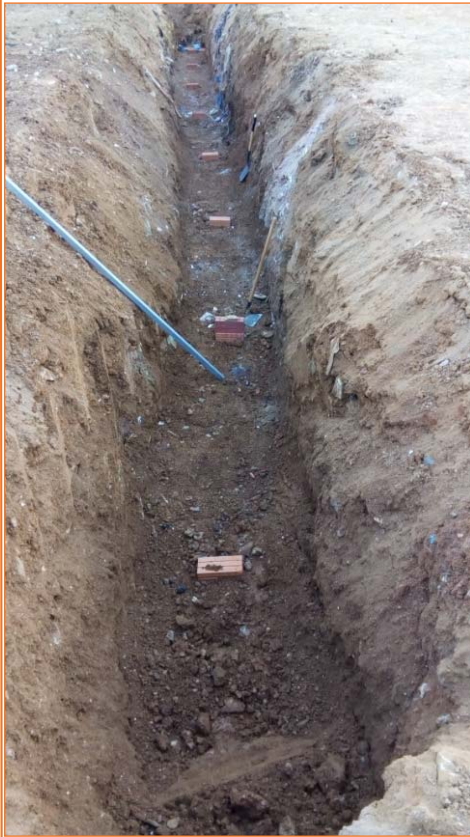
Foto 11. Vista de la Rasa pel nou col·lector d'aigües pluvials a la zona central.
