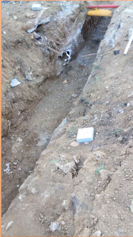
Foto 13. Vista de la Rasa pel nou col·lector d'aigües pluvials a la zona est.
