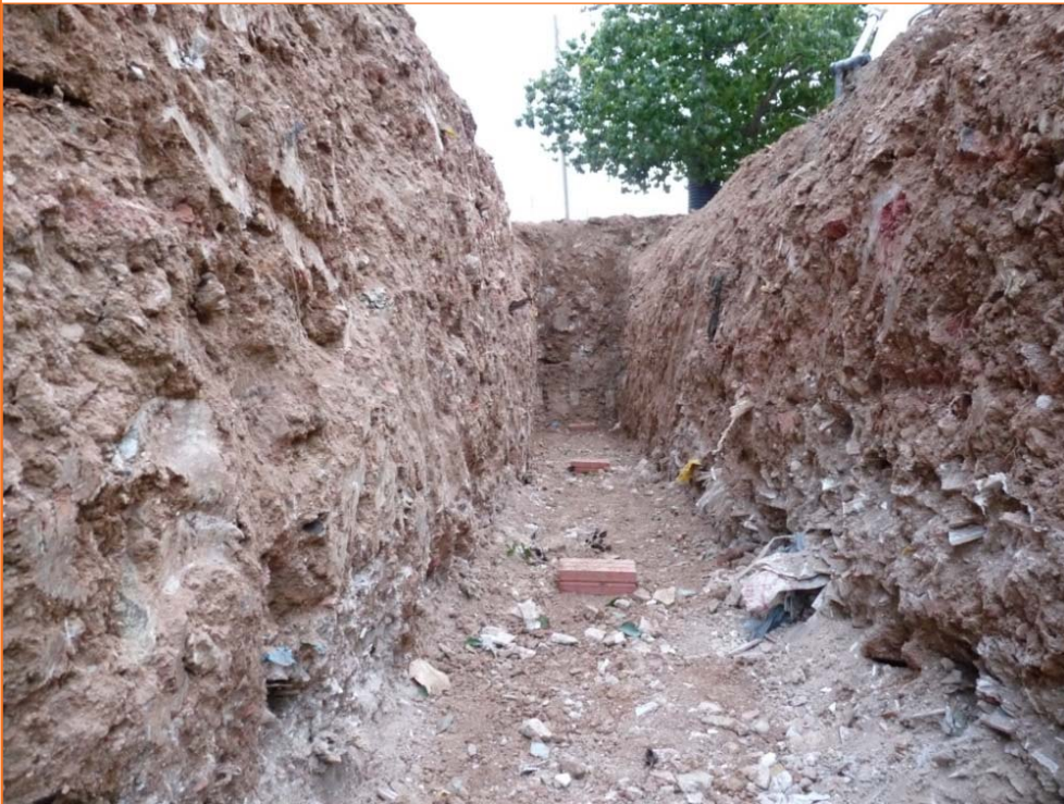
Foto 15. Detall del tall estratigràfic del nou col·lector d'aigües pluvials.
