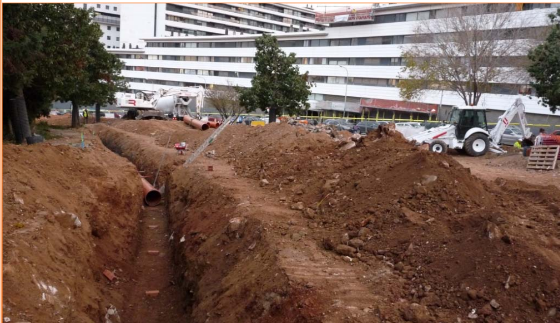
Foto 8. Vista de la Rasa pel nou col·lector d'aigües pluvials a la zona oest.
