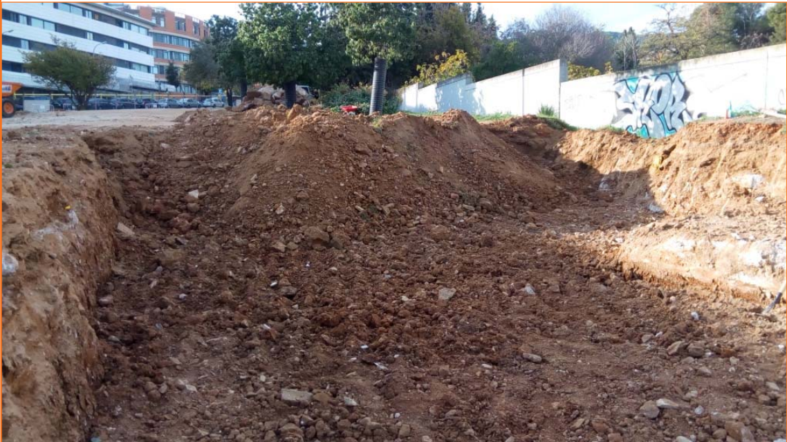
Foto 5. Vista del rebaix a la zona més a l'est del solar.
